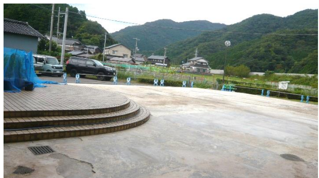
工事が進む「グリーン広場」
